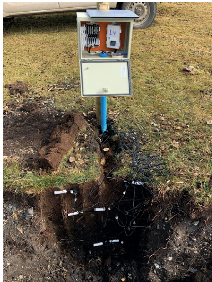
Figura 3. Sensores y Data Logger dispuestos en una calicata en E.E. Kampenaike.
