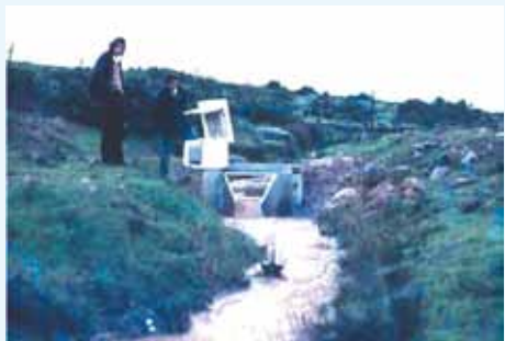
Foto 5. El agua de escurrimiento debe ser tanto infiltrada en el suelo como almacenada para riego durante el período de precipitaciones.
