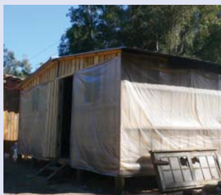
El lado externo de los paneles se protege con polietileno corcheteado a los pie-derechos.
