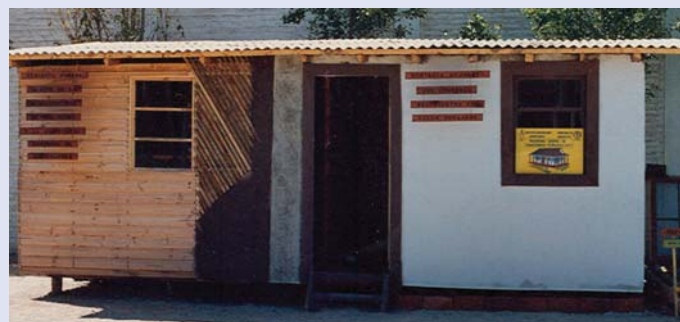
El modelo de la foto muestra cómo va el entramado de madera y el relleno, así como el aspecto final de la pared externa.
