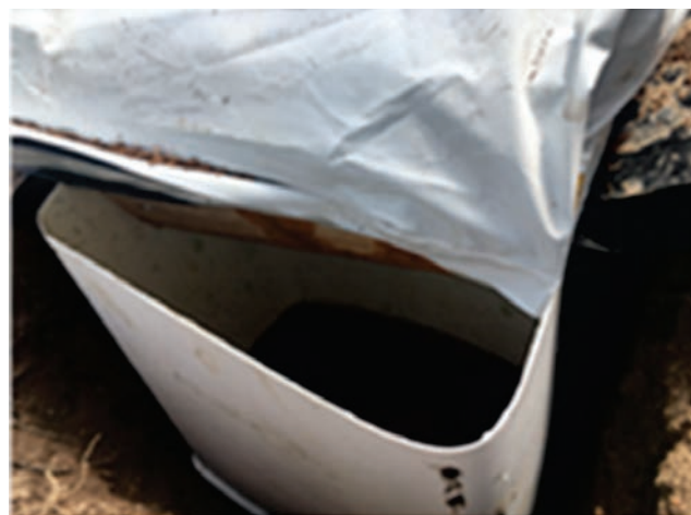
Figura 2. Bandeja de drenaje.
