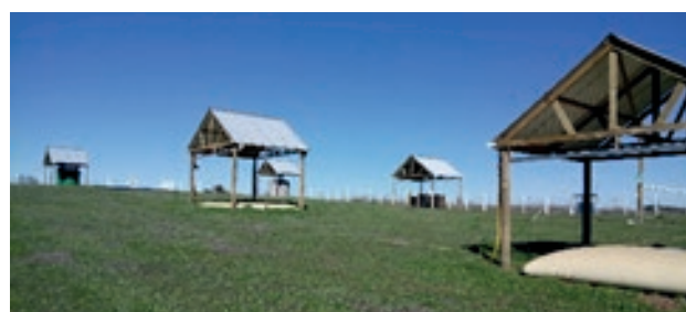
Figura 1: Sistema de colecta de aguas lluvia con techo, Hidango, Región de O'Higgins.
