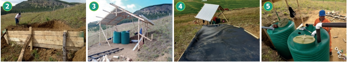
Figura 2: Terraplén construido para instalar sistema de colecta en techo. 3: Sistema de cosecha de agua lluvia en techo y estanques de acumulación. 4: Sistema de cosecha de agua lluvia en suelo. 5: Conducción de agua lluvia hacia los estanques de acumulación.
