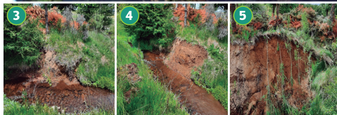
Figura 2: Estacas de álamos establecidas en zona de crecidas del cause. 3: Zona de ribera con peligro de erosión. 4: Corrección de talud para el establecimiento de estacas arbóreas. 5: Establecimiento de estacas de sauce en forma vertical en talud corregido.
