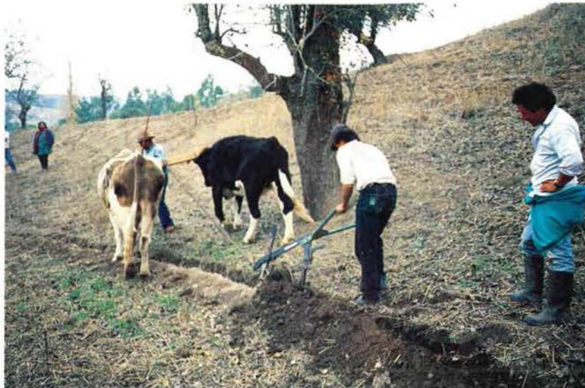
Construcción de curvas de infiltración.
