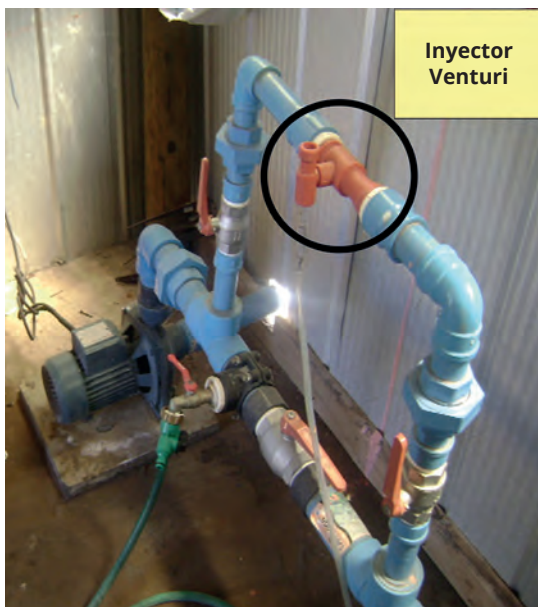
Figura 11.17. Esquema de instalación de inyector Venturi.
