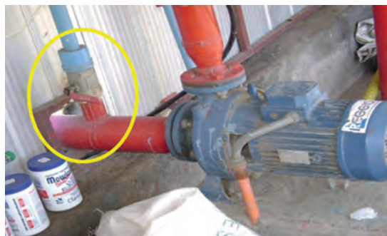
Figura 11.15. Inyección de fertilizante por succión de la bomba.
