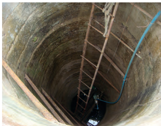
Figura 6.7. Pozo noria revestido con tubos de hormigón.
