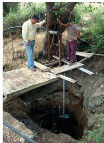
Figura 6.5. Pozo noria. Alternativa muy usada en zonas de secano para la extracción de agua.
