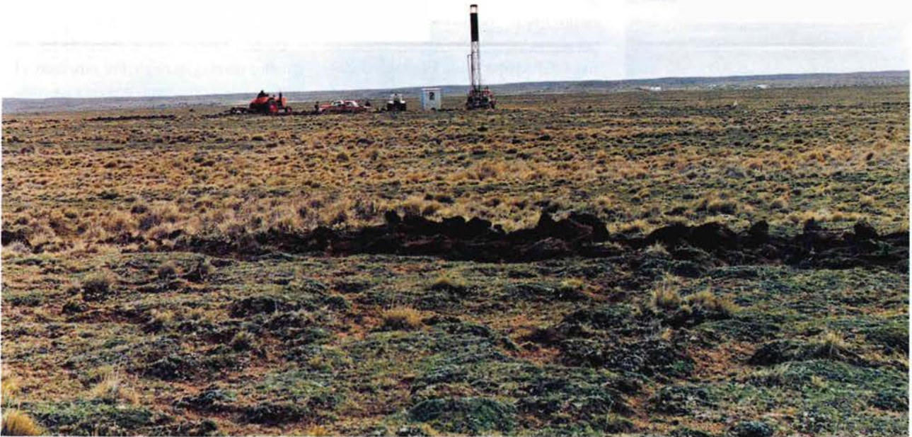
El inicio de la ejecución del proyecto. Perforación de pozos y preparación del suelo
