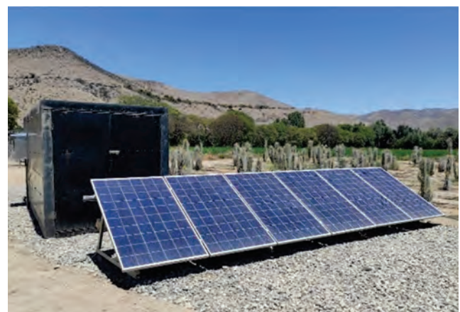
Figura 2. Container deshidratador solar instalado con sistema fotovoltaico complementario.
