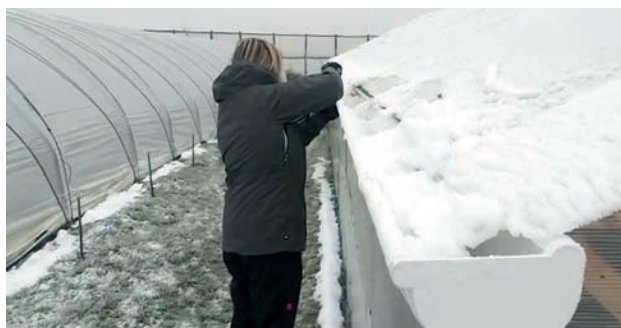
Figura 1. Se debe sacar la nieve de las canaletas, para disminuir el peso. Puerto Natales, 2021.
