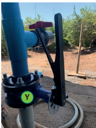
Figura 3. Válvula mariposa (Y) al final del cabezal de riego.
