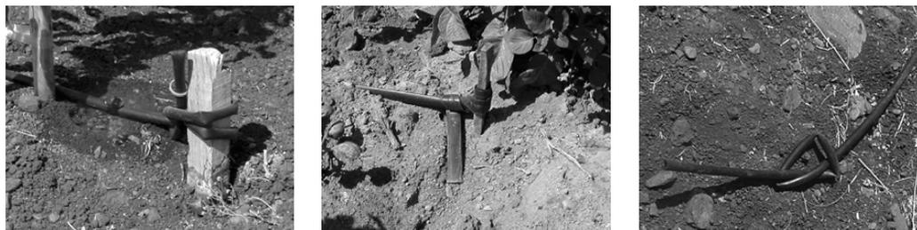
Figura N° 6.11. Esquema de instalación de un «flushing manifold» para lavado de laterales en invernaderos
