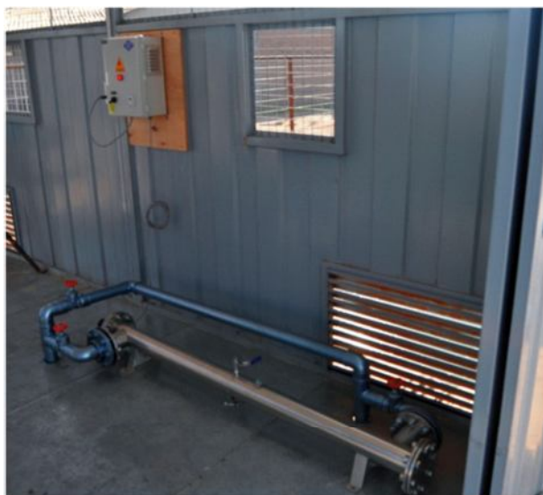
Figura 8. Lámpara emisora de rayos UV-C a 254 nm.
