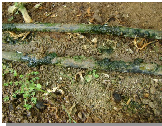
Fig.2. Obstrucción por causas biológicas
