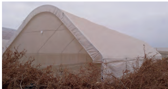
Figura 3. Invernadero de acero galvanizado tipo israelí con malla antiáfido en el valle de Azapa, Arica.
