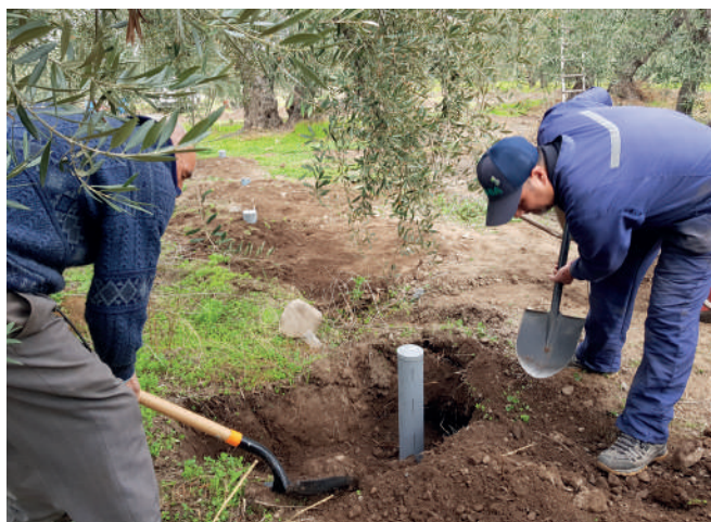
Figura 5. Colocación y tapado del tubo vertical.
