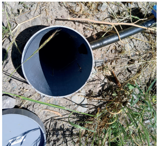
Figura 10. Tubería polietileno 16 mm conectada al tubo vertical.
