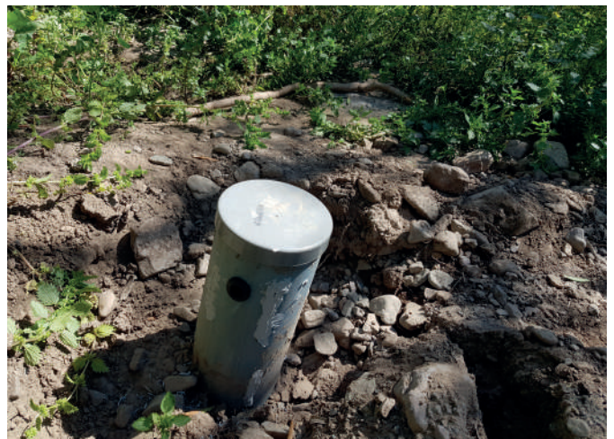
Figura 9. Tubo con goma gromit instalado.
