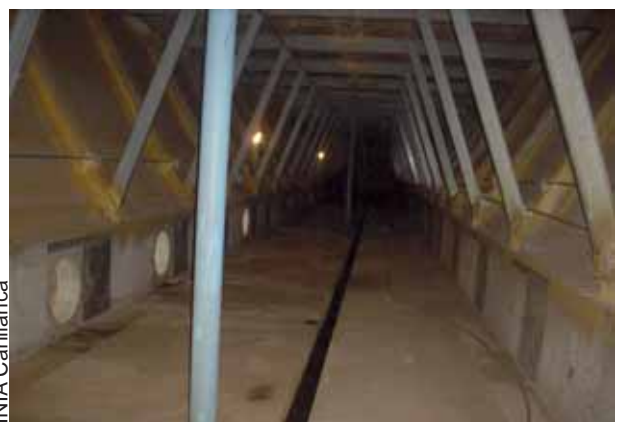
Bodega de UNISUR. Túnel de viento para la ventilación de las papas.
