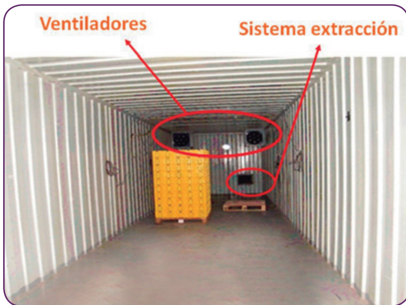
Foto 15. Cámara de gasificación con \text{SO}_2 para arándanos de exportación.
