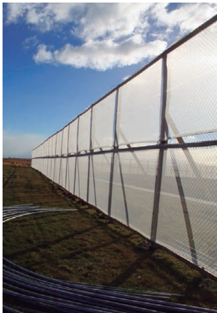
Figura 13. Cortina cortaviento perimetral, construida con malla metálica y malla plástica.
