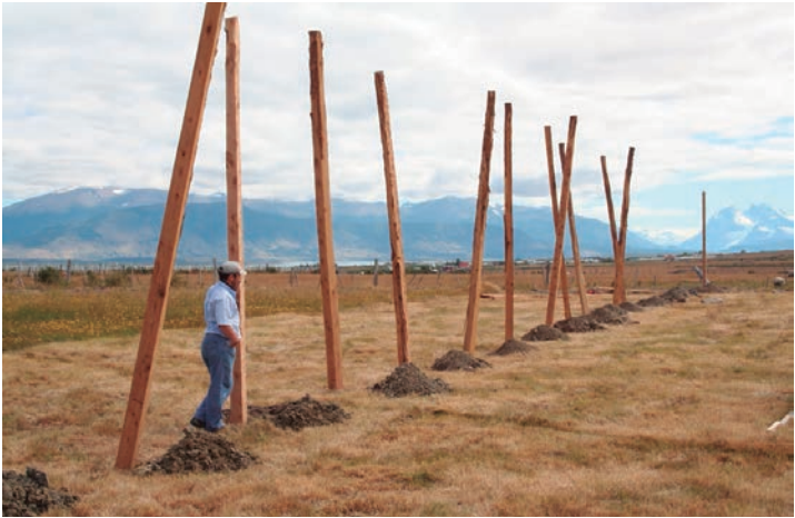
Figura 12. El establecimiento de postes a una adecuada profundidad, es clave para la estabilidad de la cortina.
