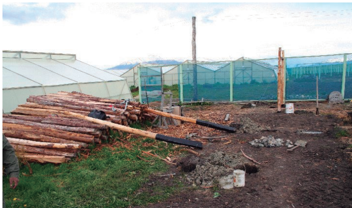
Figura 11. Postes de cipres, descascarados y alquitranados en el extremo inferior.
