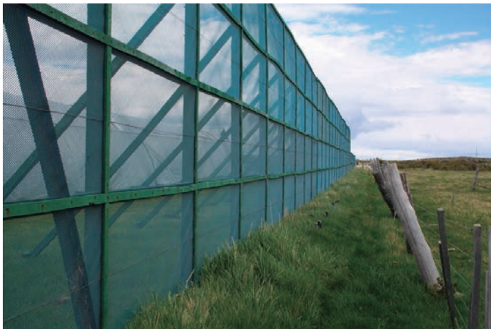
Figura 5. Cortina cortaviento de 4 m de alto.
