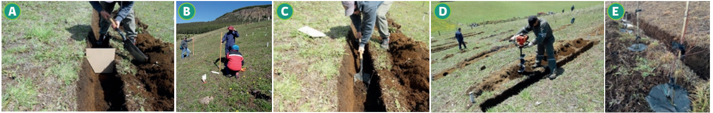
Figura 2 A: Zajas de infiltración de 0.3 m base, 0.3 m altura y 0.4 m abertura superior. B: Determinación de curvas de nivel en terreno, para construcción de las microterrazas. C: Construcción de zanjas de infiltración y acumulación de suelo pendiente abajo. D: Ahoyadura para la plantación de arbustos y árboles. E: Plantas de lengas con cubierta antimalezas y entutorado en zanjas
