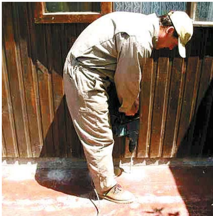
Foto 1. Perforación de piso para la inyección de insecticida en el suelo.
