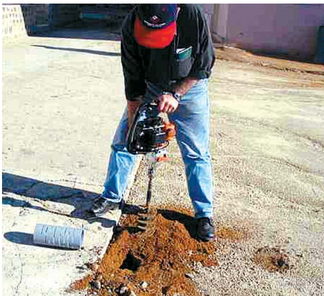
Foto 3. Instalación de estaciones de monitoreo en módulo.
