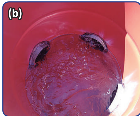
Foto 7. Tambor regulador de presión y distribución de agua. (a) Vista de uniones por fuera e (b) interior
