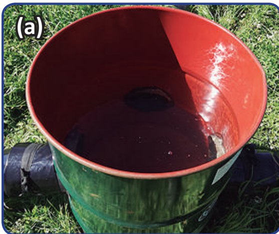
Foto 7. Tambor regulador de presión y distribución de agua. (a) Vista de uniones por fuera e (b) interior
