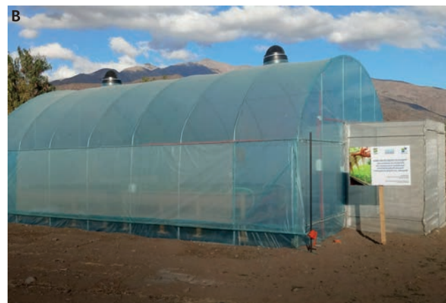
Figura 2. Diseños de uso común en la región de Coquimbo. A. Invernadero tipo capilla a dos aguas. Programa acuaponía INIA/UCN, 2021. B. Invernadero tipo túnel. Programa hidropoñía zonas rezagadas Coquimbo, 2019.
