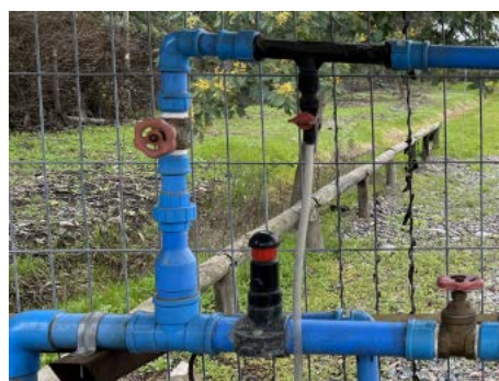
Figura 3. Vista de los componentes del sistema de fertirriego, Venturi.
