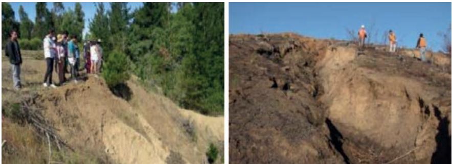
Foto 10.2. Erosión de origen hídrico en suelos de la Cordillera de la Costa y Secano Interior de la Región del Biobío, sector de Rafael (izquierda) y Tomeco (derecha). Fotografía Eduardo Peña.
