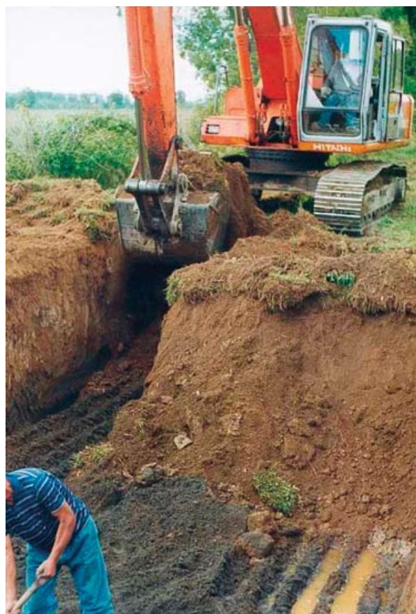
Foto 8. Preparación de un dren tipo zanja.
