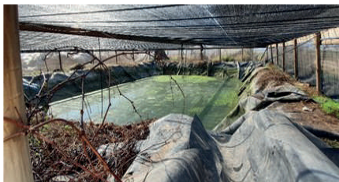
Figura 3. Tranque revestido con geomembrana y cobertura de malla raschel, con presencia de algas debido a falta de mantención y sombreado insuficiente.
