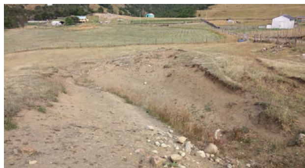
Figura 1: Erosión de laderas en cárcava. Villa Ortega, región de Aysén
