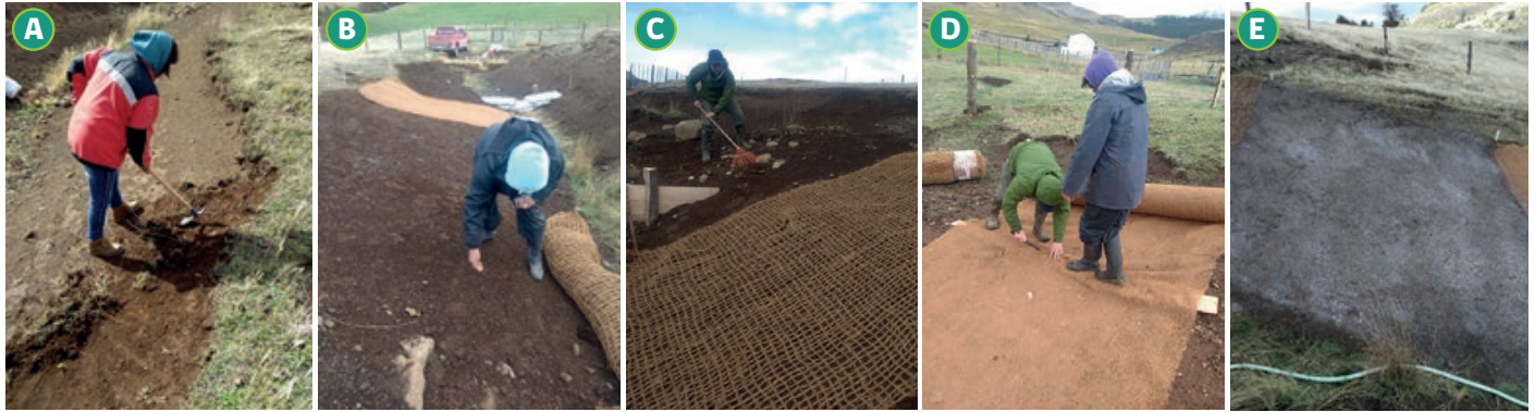
Figura 2 A: “Peinado de la cárcava” para eliminar bordes degradados. B: Siembra y fertilización al voleo. C: Siembra y fertilización al voleo, más protección con geomalla. D: Siembra y fertilización al voleo, más protección con geomanta. E: Hidrosiembra en ladera erosionada de la cárcava.
