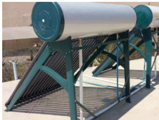
Figura 8. Equipos solares térmicos de 180 y 120 L en el km 21 del Valle de Azapa. Fuente: INIA Ururi (2016).
